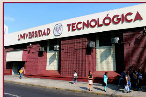
Edificio Giuseppe Garibaldi
