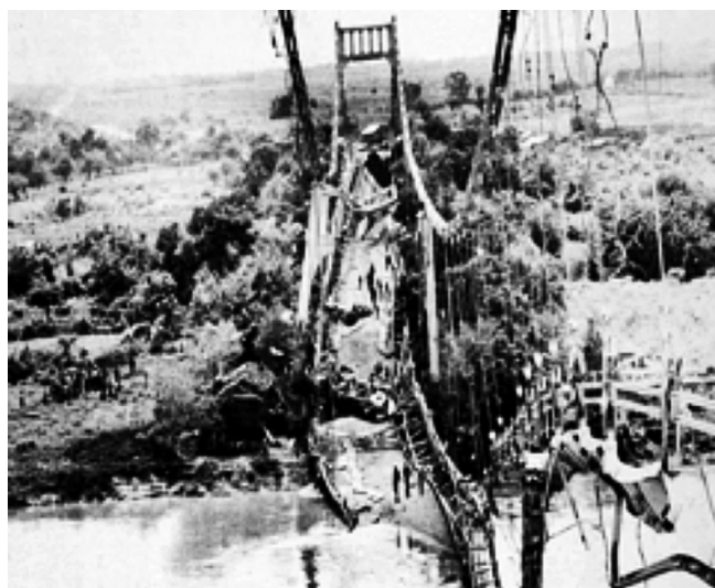
Puente Cuscatlán sobre la carretera Panamericana, y Puente de Oro sobre la carretera del Litoral, antes y después de la guerra civil. El Cuscatlán fue dinamitado el 1 de enero de 1984, el de Oro el 15 de octubre de 1981.
