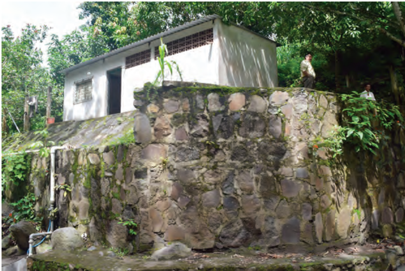
Fotografía 117. Sistema de agua potable en Santa María Ostuma, ubicado en el Cantón y caserío El Transito. Fotografía tomada por Miguel Ángel Hernández Vásquez.
