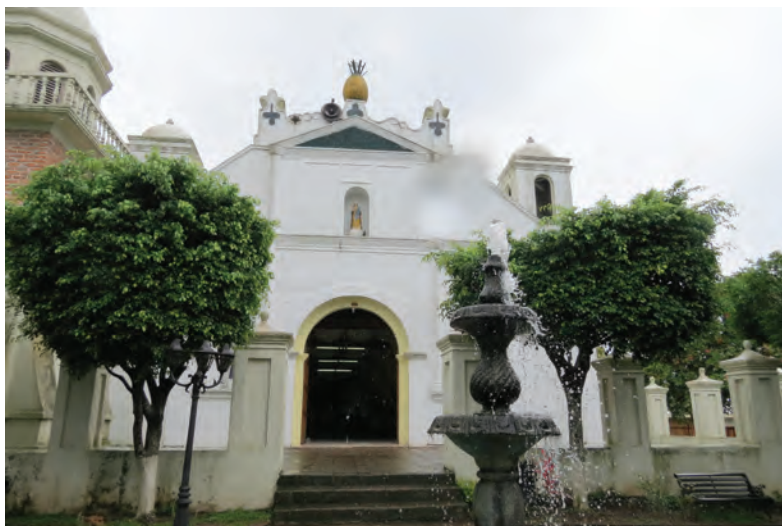
Fotografía 49. Fachada de la iglesia parroquial de Santa María Ostuma, edificada en honor a la Virgen de Candelaria. (Fotógrafo: Miguel Ángel Hernández Vásquez)
