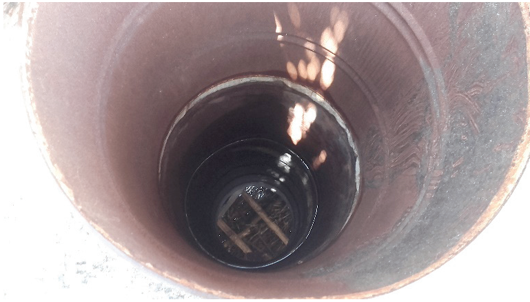
Figura 38. Estanque excavado en la tierra y construido con barriles metálicos
