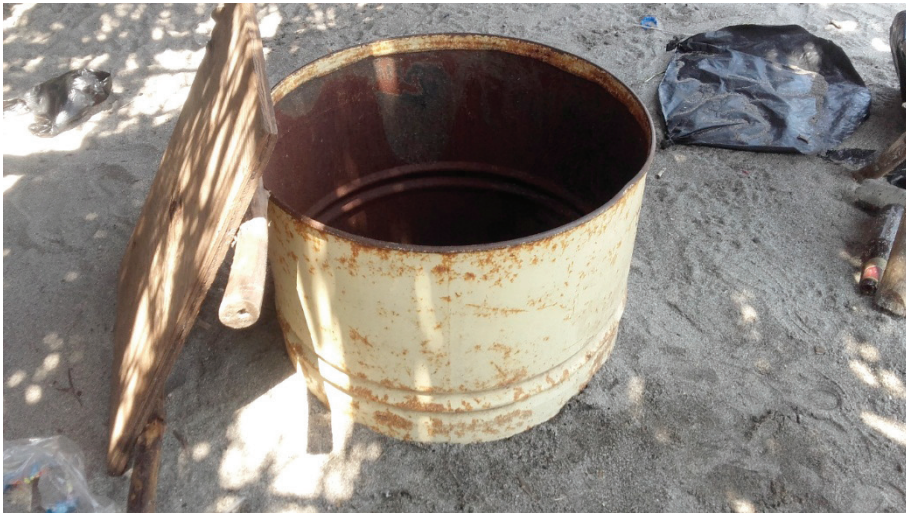
Figura 39. Estanque excavado en la tierra y construido con barriles metálicos, vista en perspectiva
