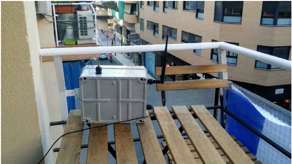
Figura 28. Montaje exterior para experimento en ciudad de Alicante, España. Fuente: diseño propio.
