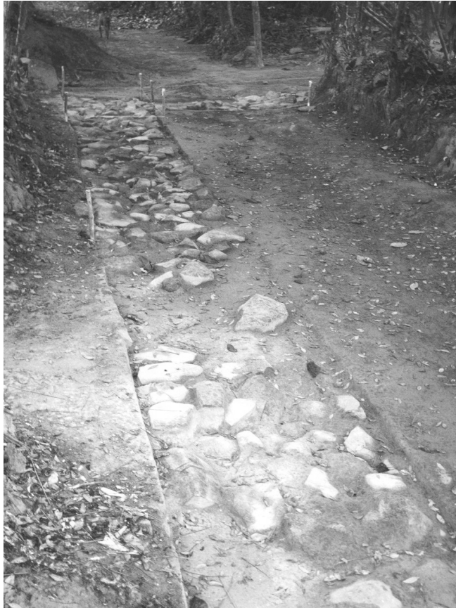
Fotografía 3. Vista de los cimientos de la esquina noreste de la estructura 4IC.
