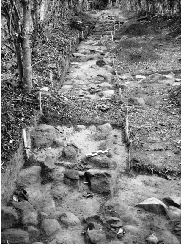
Fotografía 5. Vista general de la excavación de los cimientos de las estructuras 4IIB y 4IIB-2, que se encontraban colindantes.
