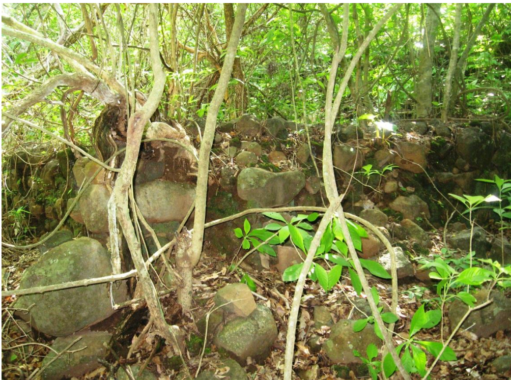
Imágenes 15 y 16 (superior e inferior respectivamente). Se muestra parte de los muros y paredes de las pilas del obraje de añil del tipo “Real”, del sitio El Marquesado III, San Vicente.
