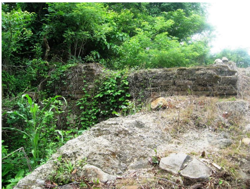
Imágenes 1 y 2 (superior e inferior respectivamente). Se muestra parte de los muros y paredes de las pilas del obraje de añil 1, del tipo “Real” del sitio Achichilco I, San Vicente.
