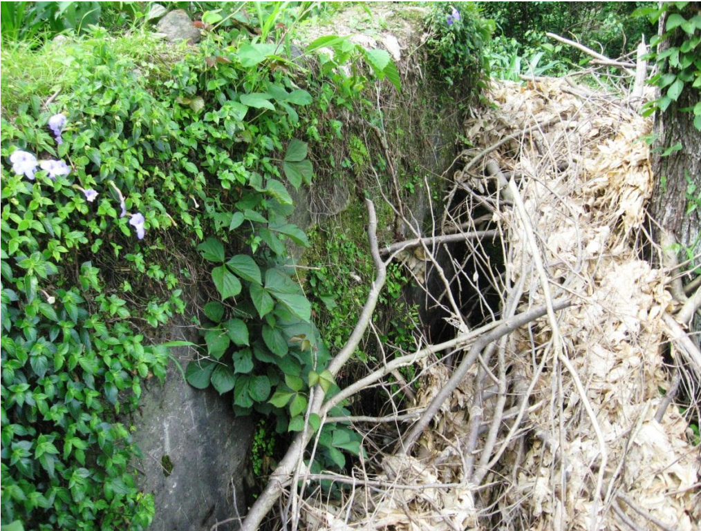
Imágenes 31 y 32 (superior e inferior respectivamente). Se muestra parte de los muros y paredes de las pilas del obraje de añil del tipo “Real”, del sitio El Paraíso, San Sebastián, San Vicente.
