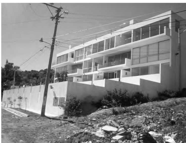
Foto 1. Skala Lofts en la colonia Escalón. Vista de la fachada del edificio. En la parte superior puede apreciarse el barandal de la terraza donde se encuentra ubicado el jardín, la piscina y el área de estar.
