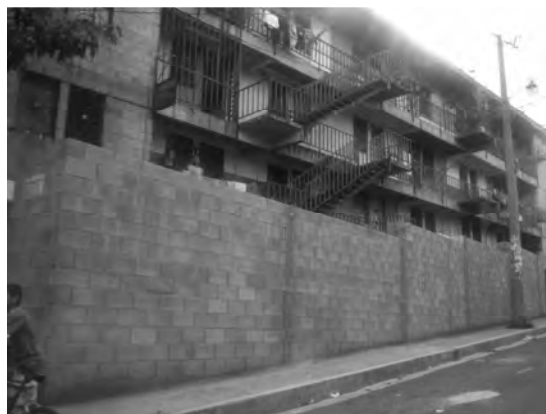
Foto 32. Vista de la fachada principal de uno de los edificios que forma parte del complejo habitacional.
