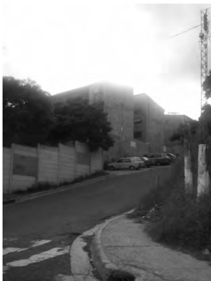
Foto 29. Vista de la entrada de la calle que conduce al condominio habitacional.
