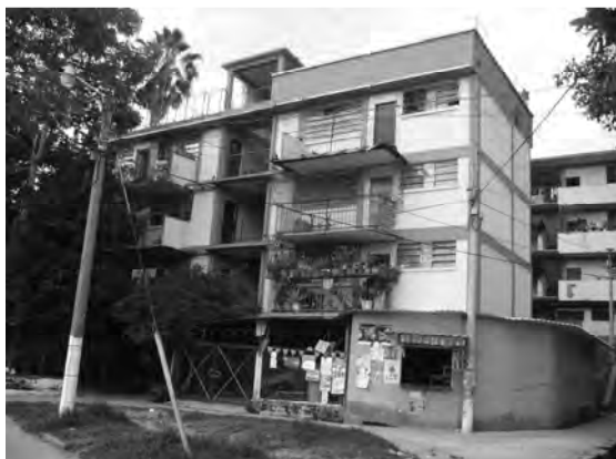
Foto 19. Fachada principal de uno de los edificios del centro urbano. (Fuente: fotografía tomada por la autora.)
