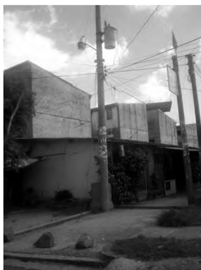
Foto 33. Vista lateral de los edificios que forman parte del complejo.
