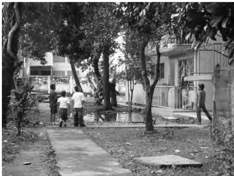
Foto 9. Situación de una de las áreas verdes dentro de Centro Urbano Candelaria, en el centro histórico de San Salvador (construido por el IVU). Nótese el charco formado por una fuga de agua frente a los niños.
