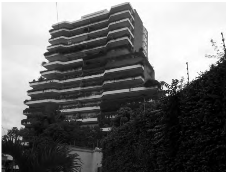
Foto 3. 525 San Benito. Vista de la fachada principal del edificio.
