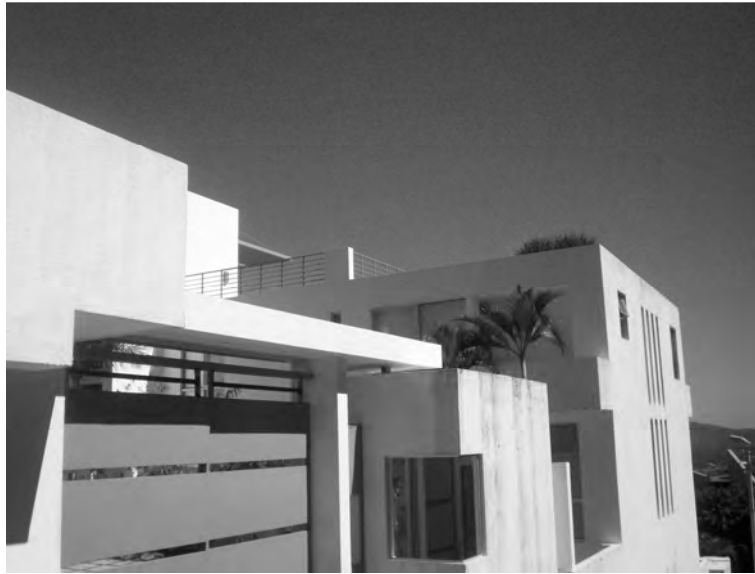
Foto 2. Skala Lofts en la colonia Escalón. Vista de lateral del edificio. Nótese la vegetación sobresaliente en la cubierta a la derecha de la fotografía.
